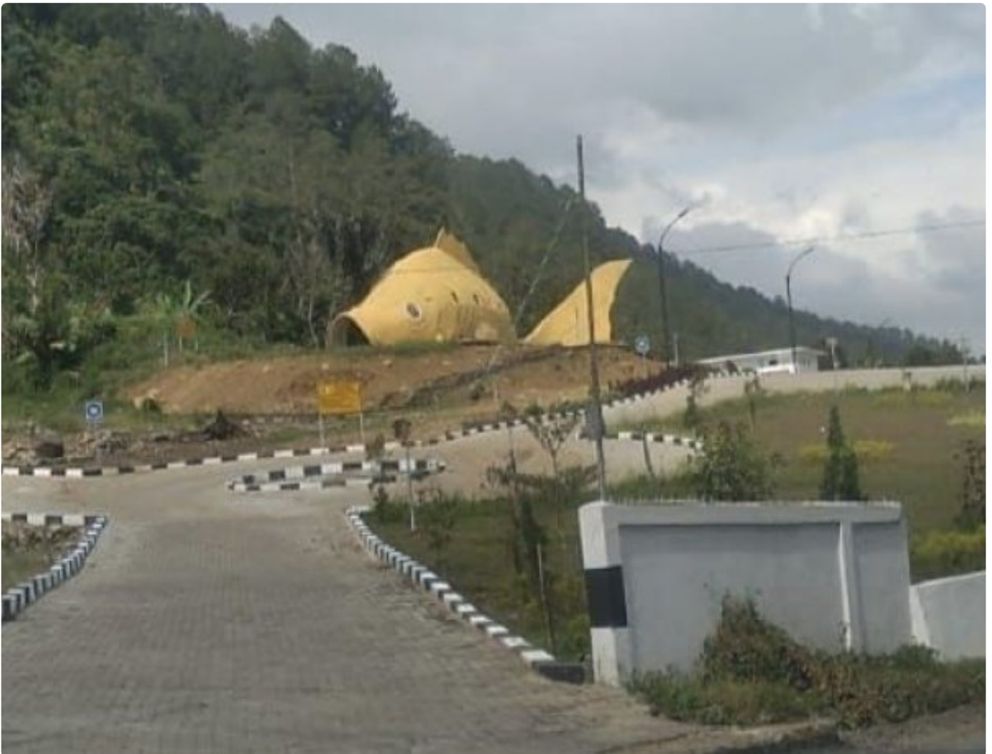
Proyek Pembangunan Ikan Mas Sipolha
